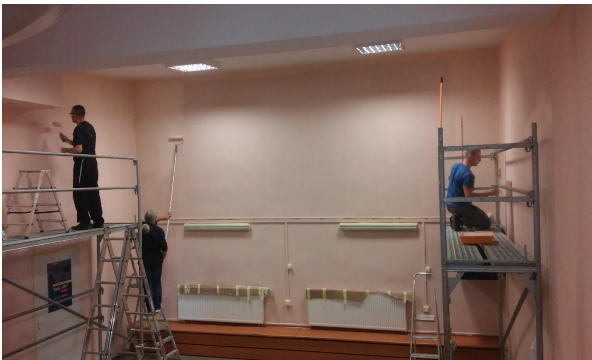
Fot. 4. Reintegracja zawodowa – remont pomieszczeń reintegracyjnych i biurowych w siedzibie CIS
